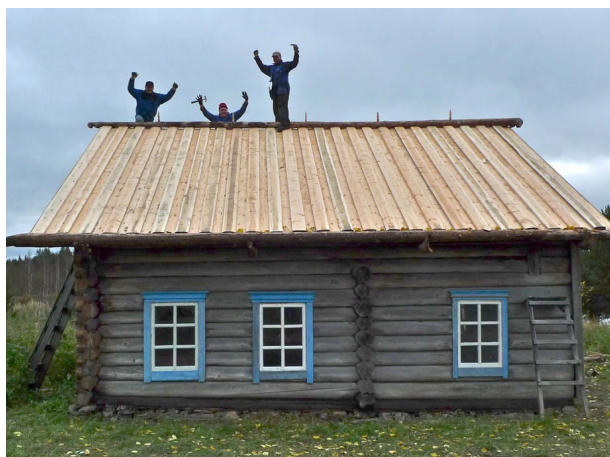
Hökkälän kattoa korjataan 2010-luvun alkupuolella. KUVA: TERO PALDANIUS
