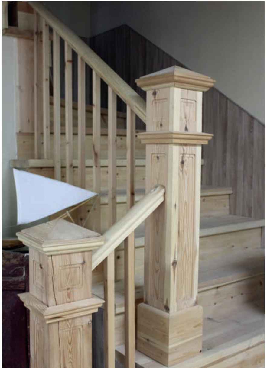
Yksityiskohta miljoonilla ruplilla kunnostetun Mobergin talon sisätiloista. Yläkerta ei ole vielä valmis.
