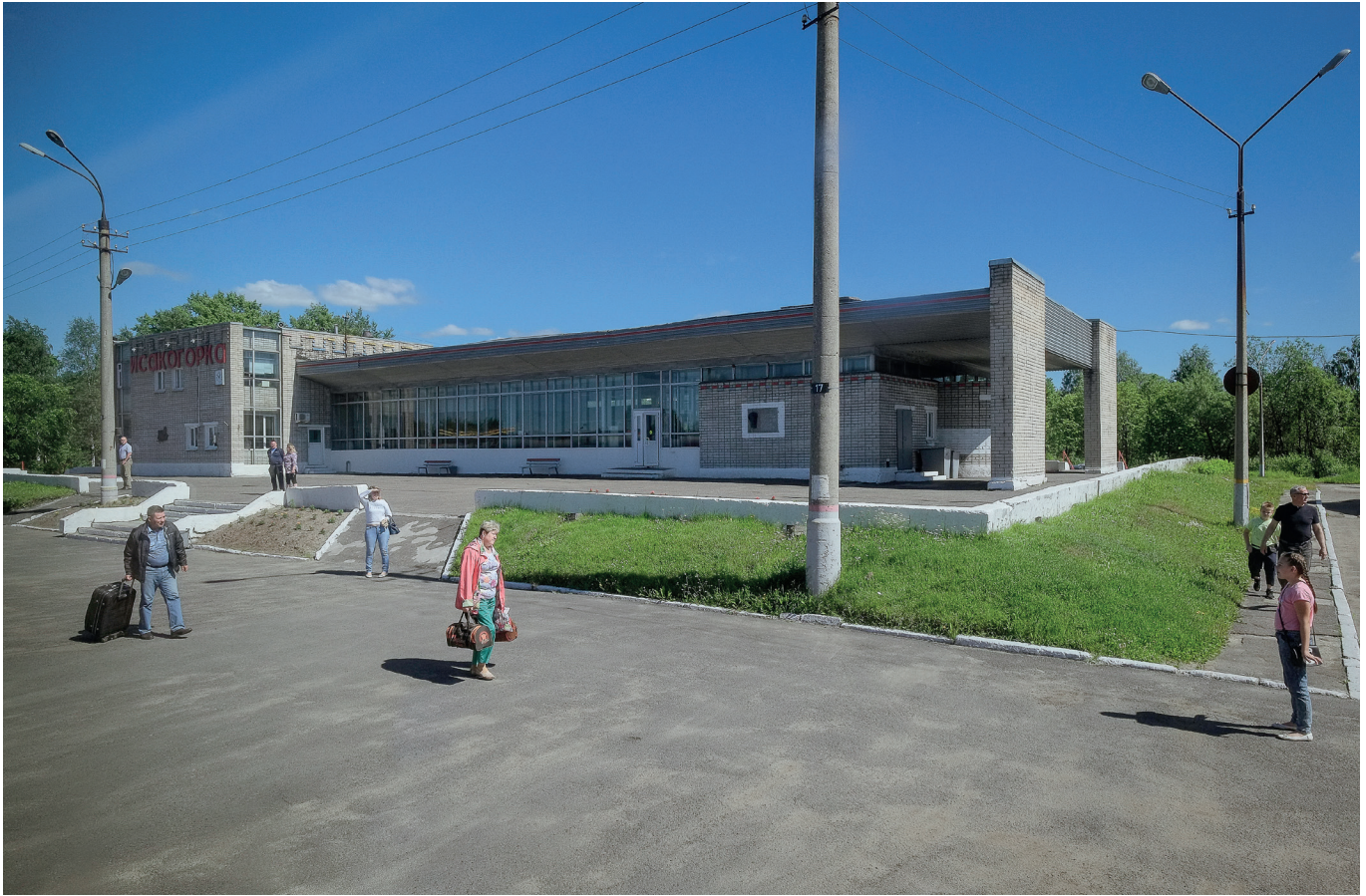
Isakogorkan rautatieasema edustaa neuvostorakentamista aidoimmillaan.
