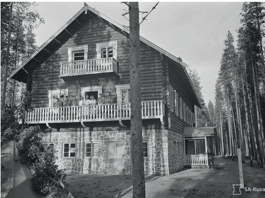
Tolvajärven matkailumajan rakennustyöt alkoivat keväällä 1938 ja se viimeisteltiin seuraavan vuoden keväällä. Talo vihittiin käyttöön 18. heinäkuuta 1939. Matkailuelinkeinon uskottiin kasvavan lähivuosien aikana Karjalan korpien kätöksissä.
