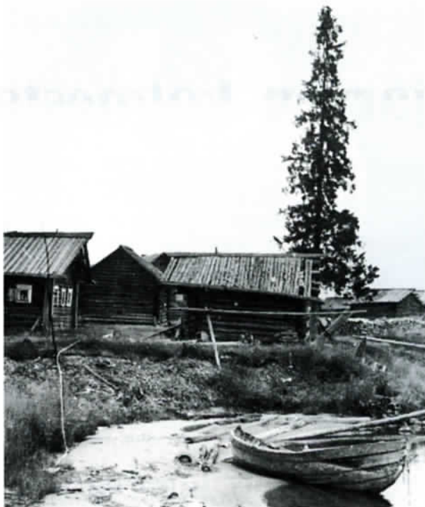
Kotikuusi vartioi tässä jo rapistumaan päässeita rakennuksia (SA-kuva).
