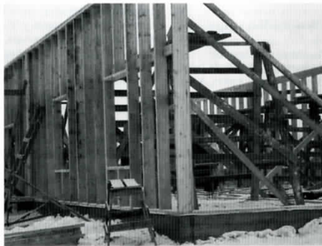
Uhtuan kirkon rakennustyömaa viime marraskuussa.
