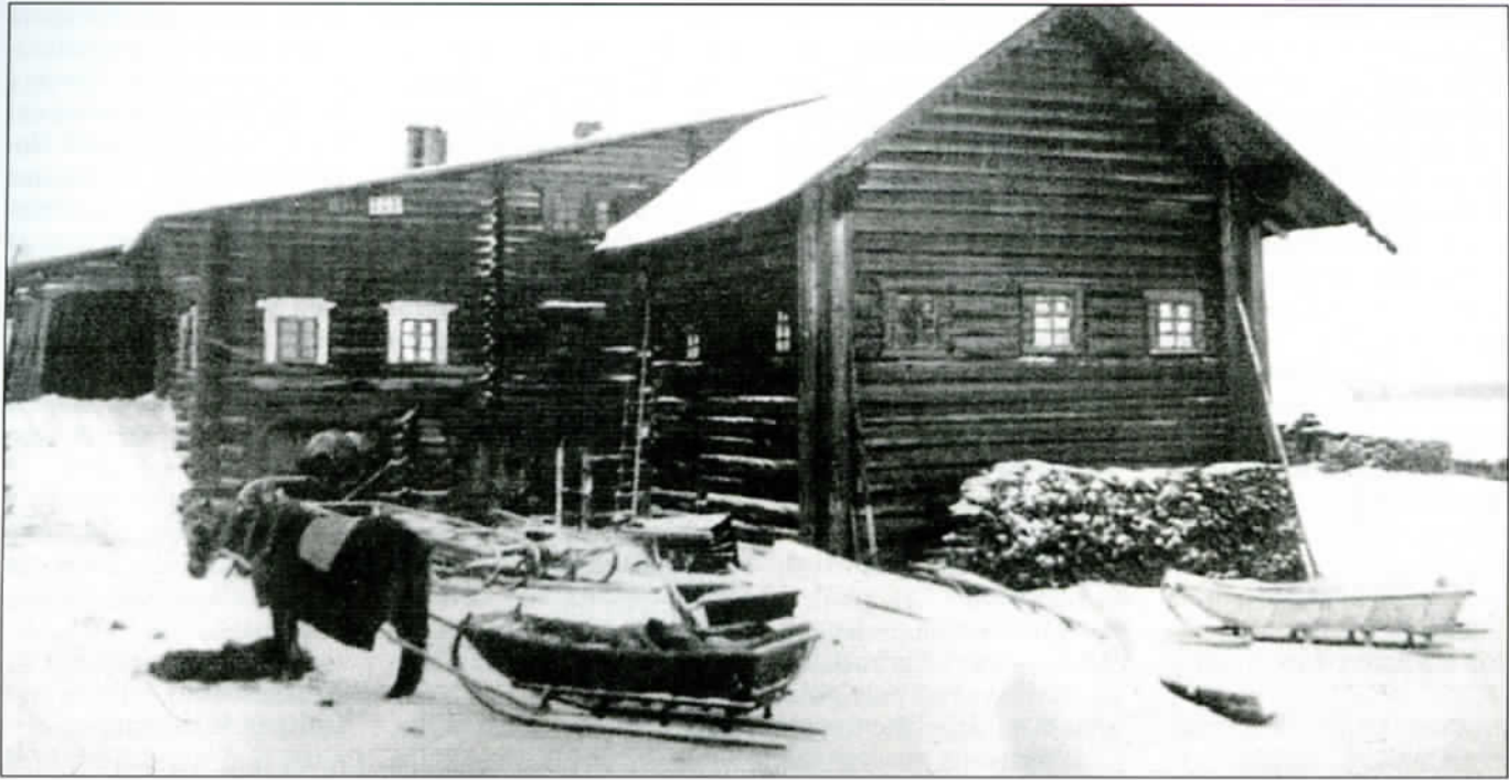
Homan Puavilan talo Luvajärvenissä. Oikealla pirtti, vasemmalla vieraskamari ja sen alla aitta sekä sivulla heinäytille johtava ajosilta ja ovi. Keskellä eteisen ovi ja sen päällä akkuna. Ylinnä pirttiräystäään kohdalla näkyy pieni kaksoisakkuna, joka kuuluu isännän yksityiseen hartauskammioon. - Kansannousun aikaan päädyssä olevan halkipinon taa kätettiin jauhoja. Kesällä 1921 bolshevikit tunkeutuivat Homan Puavilan rukouskammioon ja upseeri vaati aseella uhaten poistamaan ikonit. (Kuva Sakari Pälsi/Sota-arkisto/HSA Itä-Karjala 48-51)
