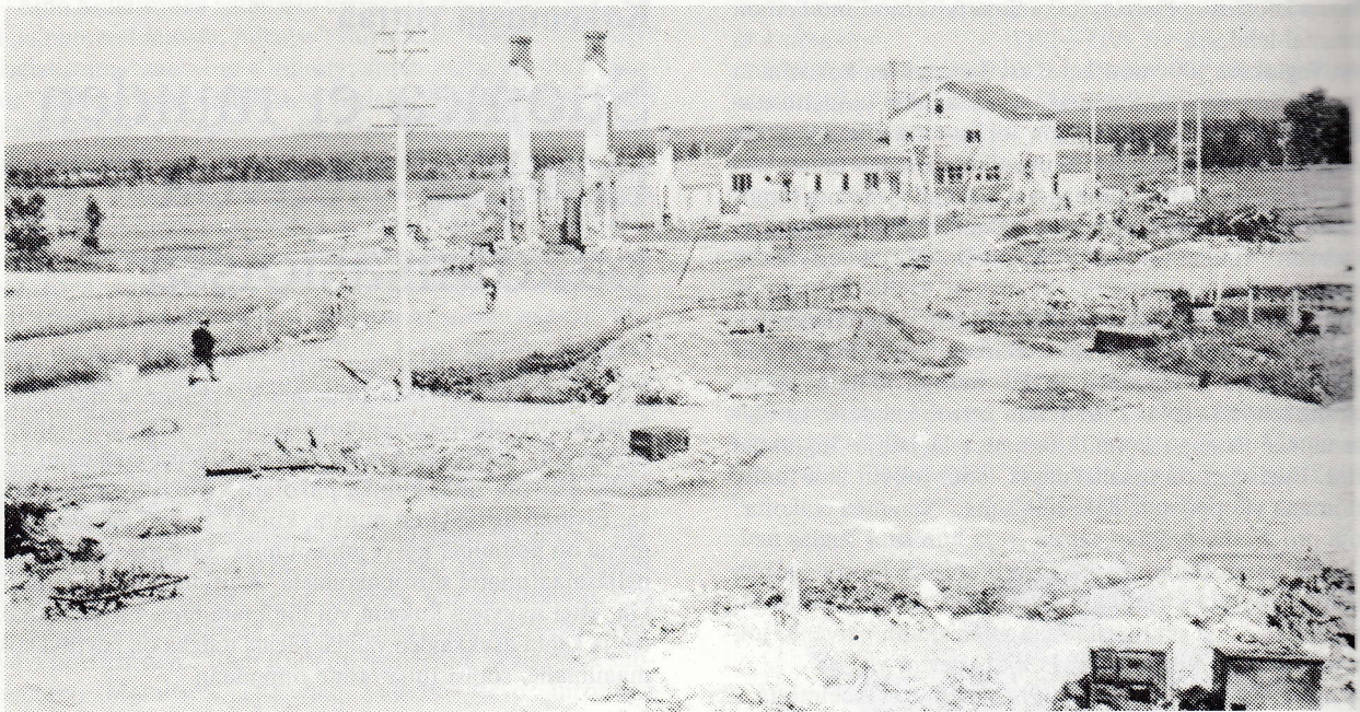
Jälleenrakennustyöt käynnissä kirkonkylän keskustassa toukokuun lopulla 1945. Kaksikerroksisesta postitoimistosta oli jäljellä vain betoniseinät; ensimmäiset uudestirakentajat asuivat talon kellarissa. — Kuva on torin kulmalta Neljän tien risteyksestä.
