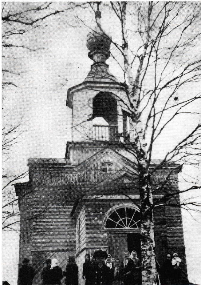
Vielä sota-aikana 1943 Paatenen Kirkköpuolen kirkko oli verrattain hyvässä kunnossa ja jumalanpalveluskäytössä. Nyt huligaanit ovat tehneet siellä selvää jälkeä. – Kuva: Pekka Jukkinilta.
