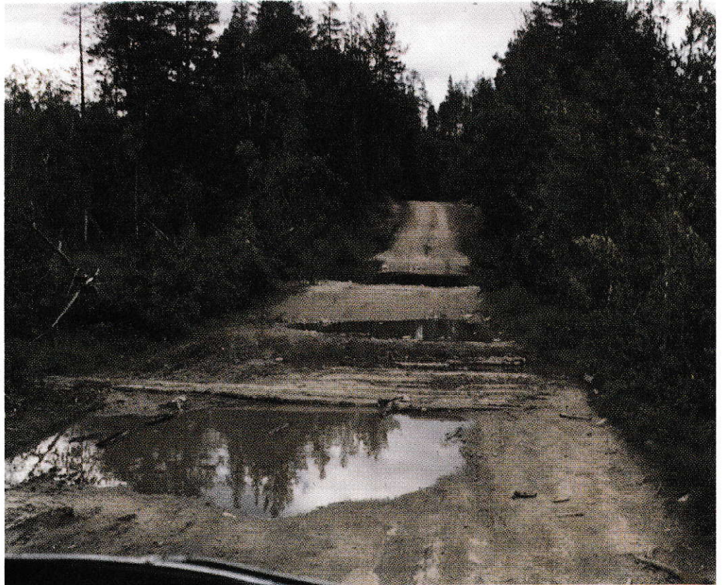
Hämeen kylään vievä tie on suora, mutta arvaamaton. Suopaikoissa vesi on kaivanut tien poikki syviä ojia, joissa auton alusta on vaarassa.
